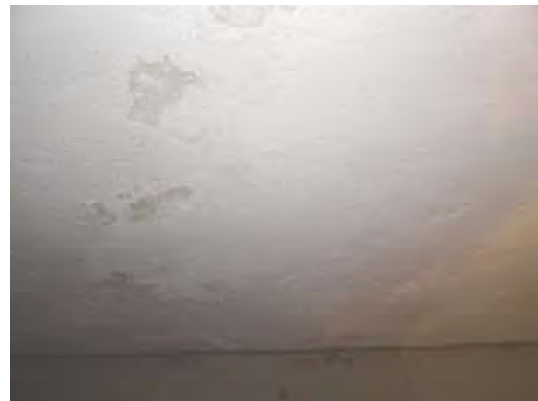
Feuchtigkeitsschäden Kellerwand Altbau
