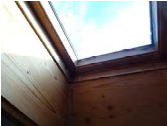
abgewittertes Dachfenster Altbau
