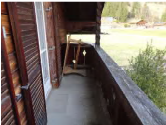
abgewitterte Holzbauteile Balkon Altbau
