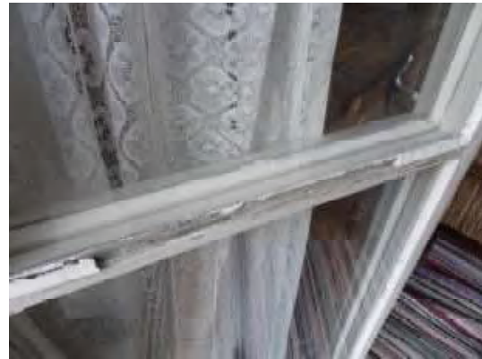
Kittausbrüche Fenster Altbau
