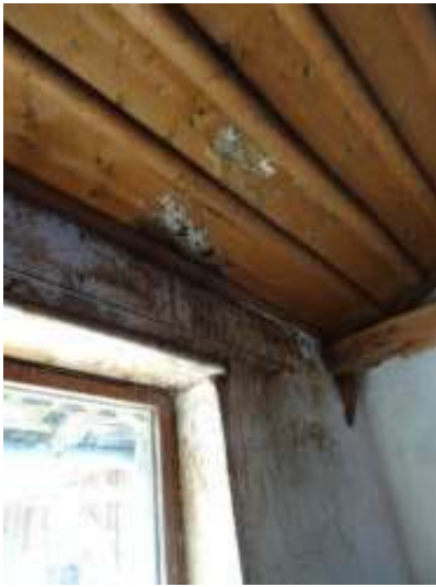
Durchfeuchtungen und Fäulnisschäden Zimmer OG
