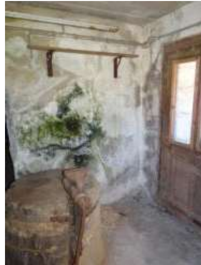
Feuchteschäden EG
