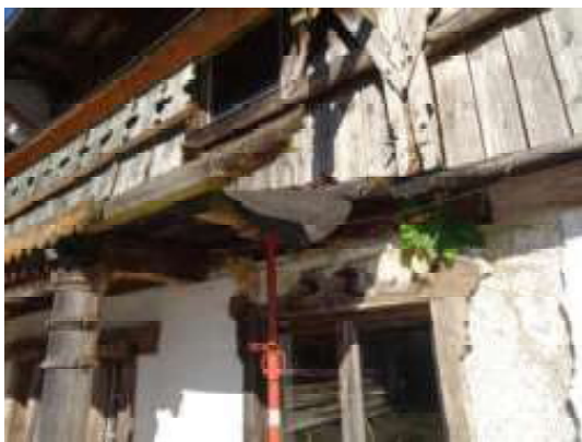
Fäulnisschäden Balkon
