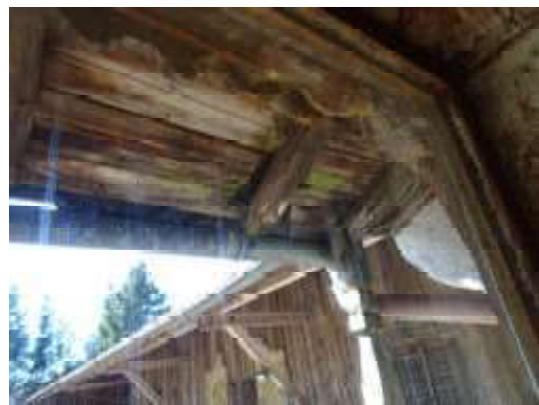
Fäulnisschäden Dachstuhl
