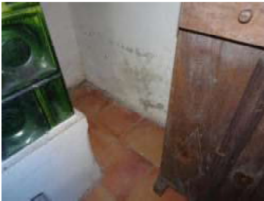
aufsteigende Feuchtigkeit Zimmer EG
