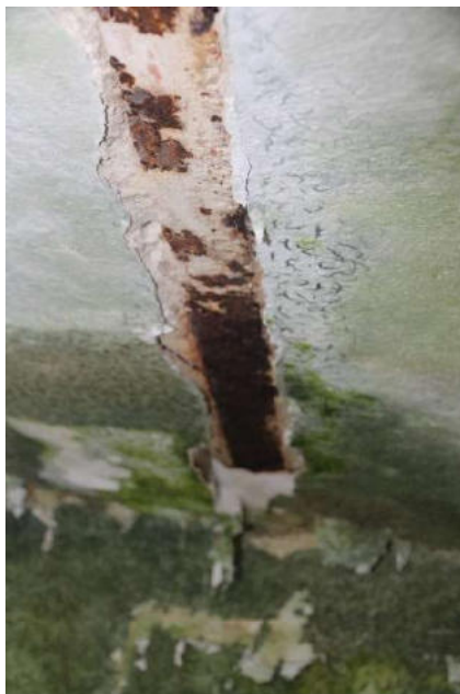
Nebengebäude – korrodierte Deckenträger
