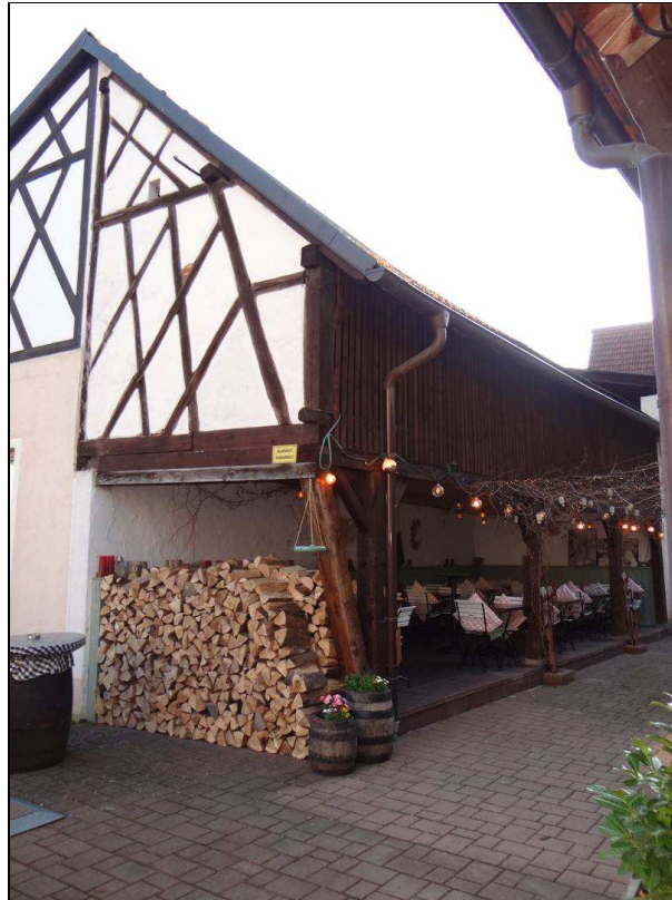
Bild 3: Nord-Ansicht des Nebengebäudes (östlicher Teil)
