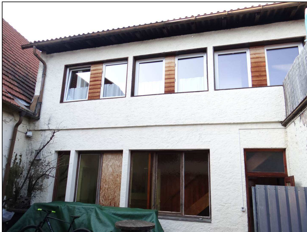
Bild 4: Süd-Ost-Ansicht des Wohn- und Geschäftshauses (westlicher Teil)
