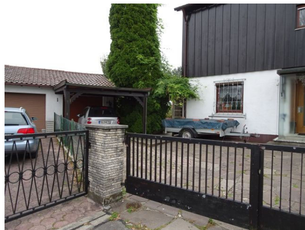
Nordwestseite, Zufahrt Garage
