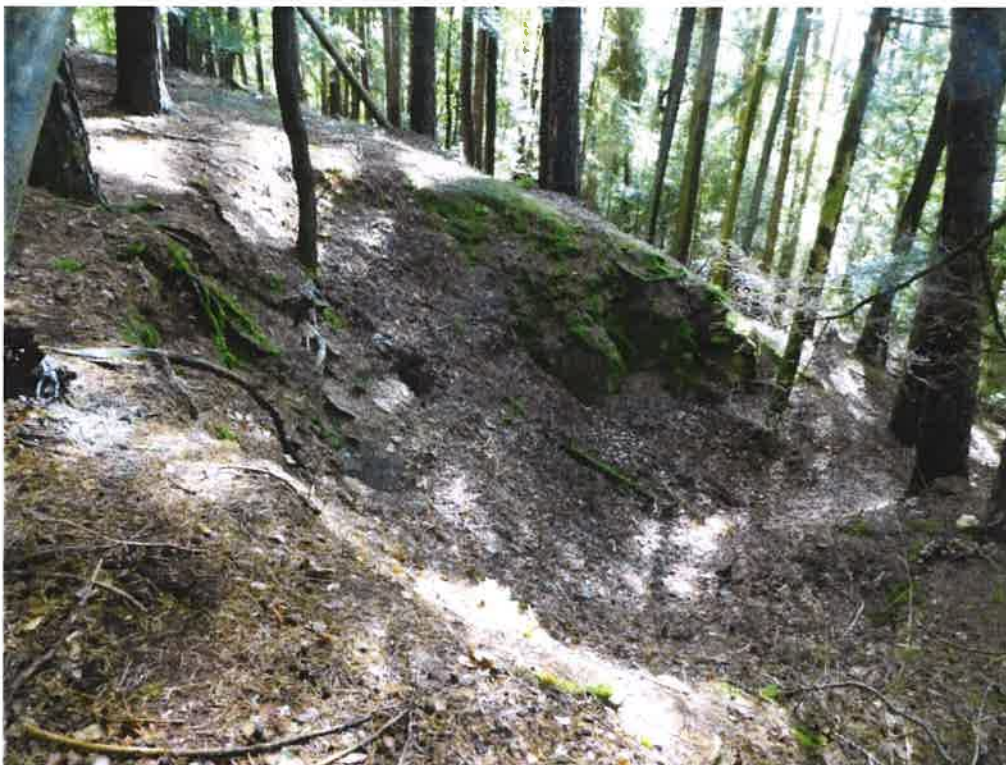
Bild 16: Fl.Nr. 556 Hangbereich Richtung Süden mit offenliegenden Sandsteinfelsen
