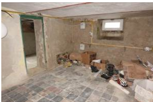
Zugang zum Abstellraum (KG)
