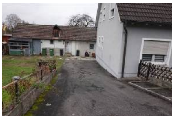
Grundstückszufahrt und -zugang
