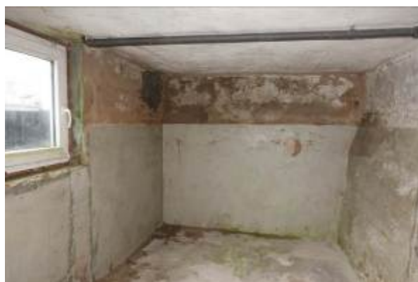
Ehemaliger Öllageraum (KG)
