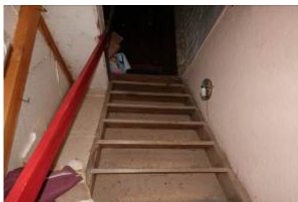
Treppe zum Dachboden (DG)
