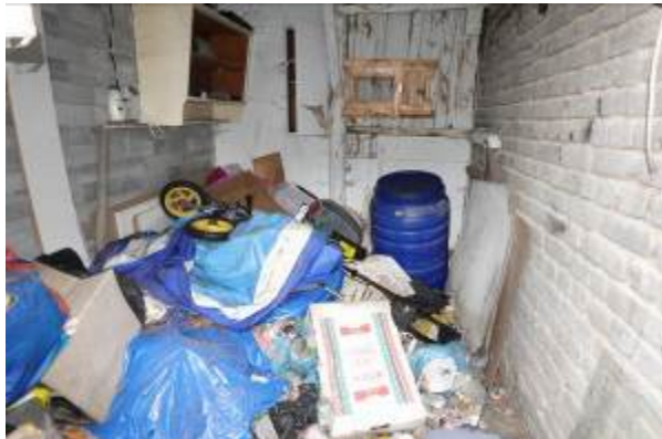
Holzlagerraum im Nebengebäude (EG)
