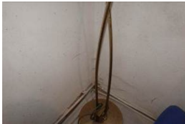
Beseitigte Schimmelbildung im Ankleideraum
