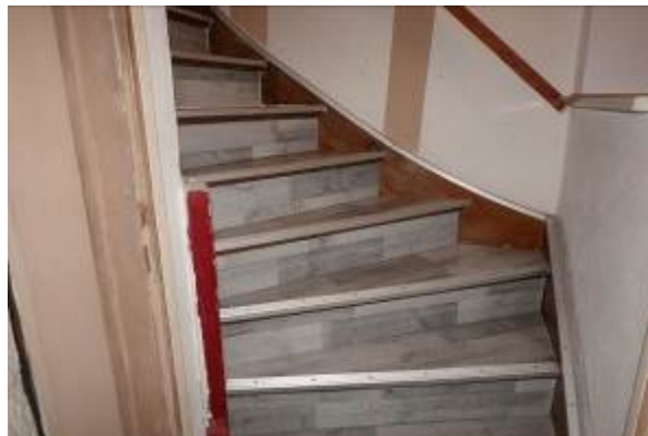
Treppe vom EG zum DG
