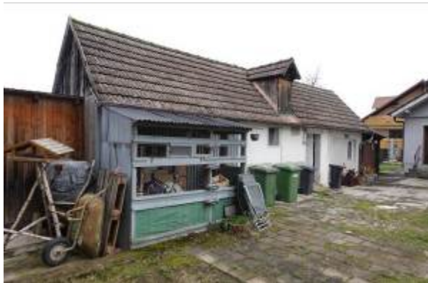
Nebengebäude, Blick aus südlicher Richtung
