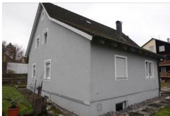
Zweifamilienhaus, Blick aus nördlicher Richtung
