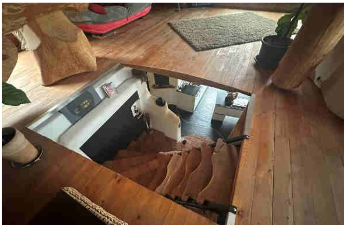
Ansicht 2 - Treppe ins 1. Obergeschoss - Altbau
