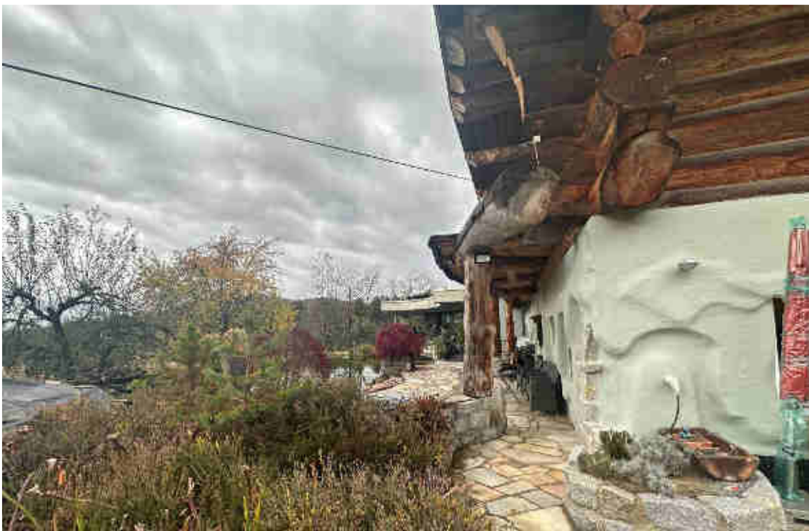
Ansicht 1 - südliche Terrasse - Altbau
