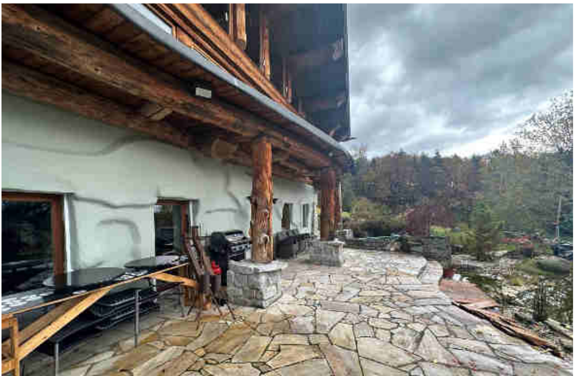
Ansicht 3 - südliche Terrasse - Altbau
