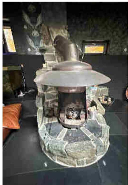
Detailaufnahme: offener Holzofen
