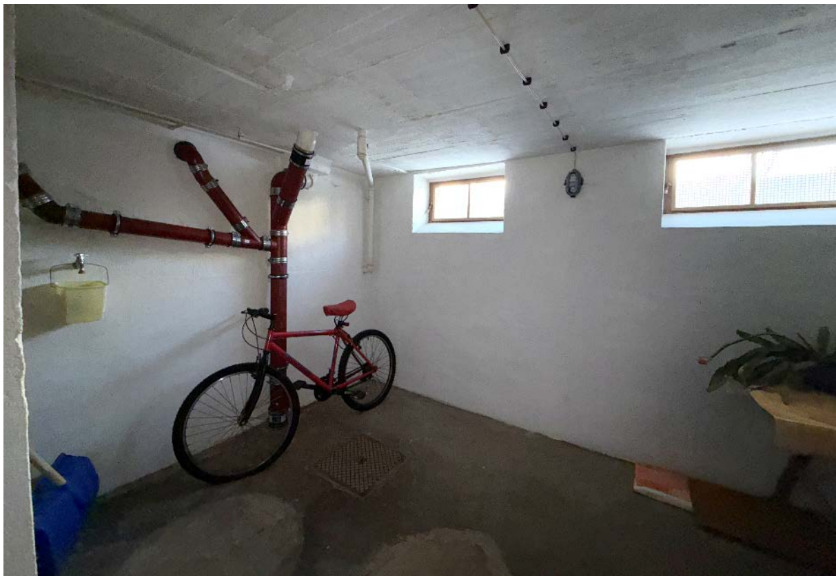
Abbildung 16 1.OG / WE Nr.3 – Gemeinschaftsanlage / Waschhaus
