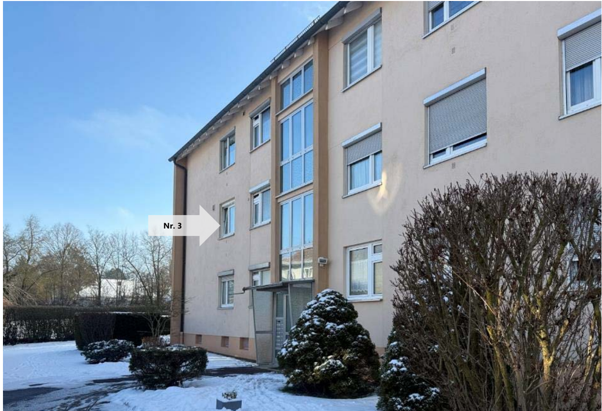
Abbildung 1 Ansicht von Nordwesten / Anliegerweg
