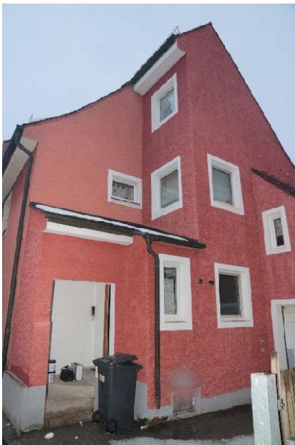
Ansicht vom Südwesten
