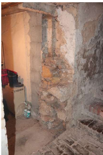
KG – Durchbruch zum Anbau
