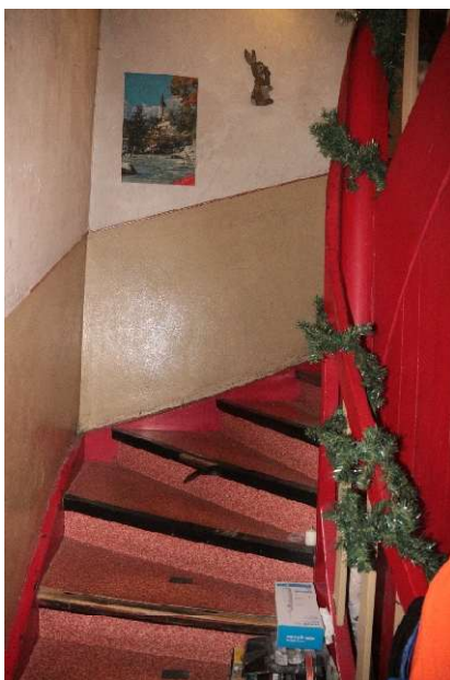
Treppe Erdgeschoss zum Obergeschoss
