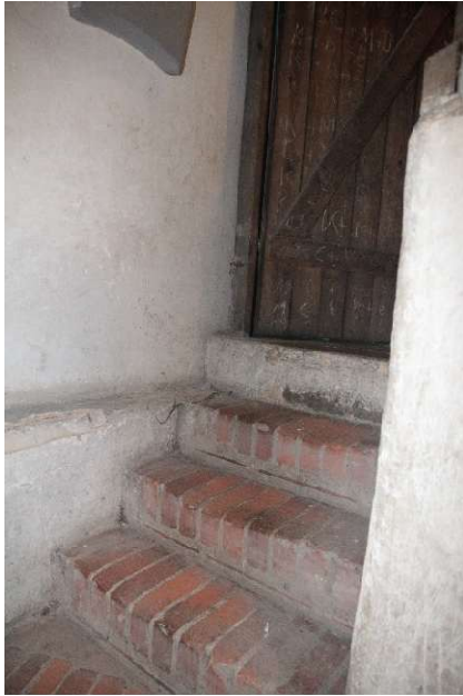
Treppe Keller zum Erdgeschoss
