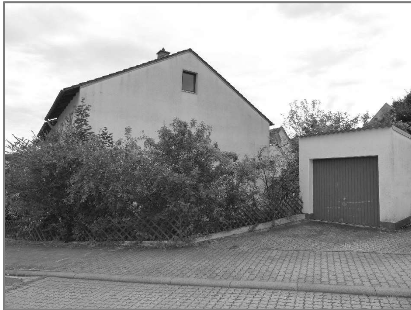
Blick auf die Südwestfassade des Reihenendhauses mit Garage Ansicht von Südwesten
