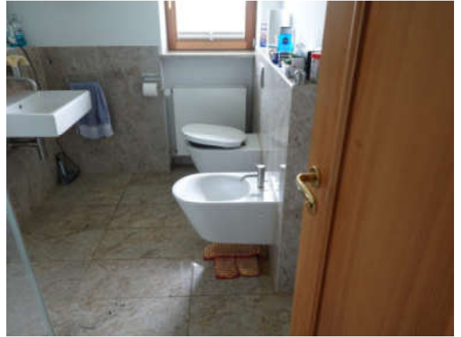
Zustand der Fenster
