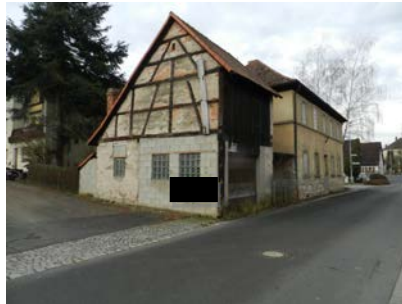
Ansicht von Osten
