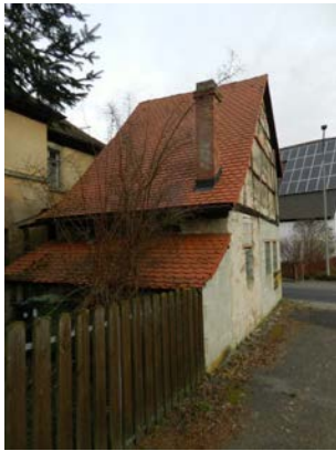
Nebengebäude, Ansicht von Süden
