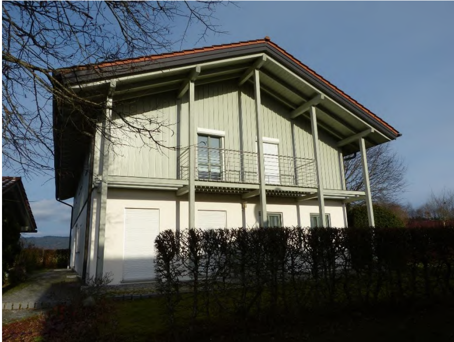
Einfamilienhaus mit 2 Einliegerwohnungen, Ansicht von Südwesten
