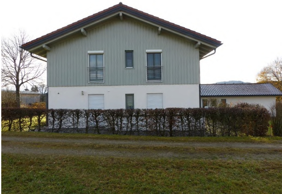
Einfamilienhaus mit 2 Einliegerwohnungen, Ansicht von Nordosten
