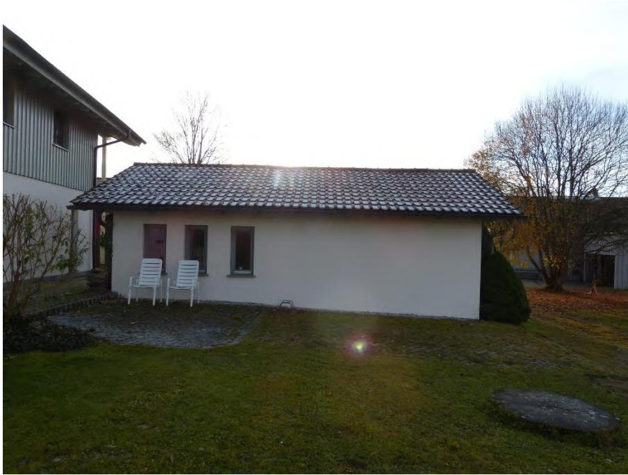
Doppelgarage mit Geräteraum, Ansicht von Nordosten
