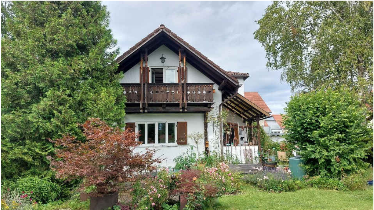
Foto 1 – Einfamilienhaus von Südwesten
