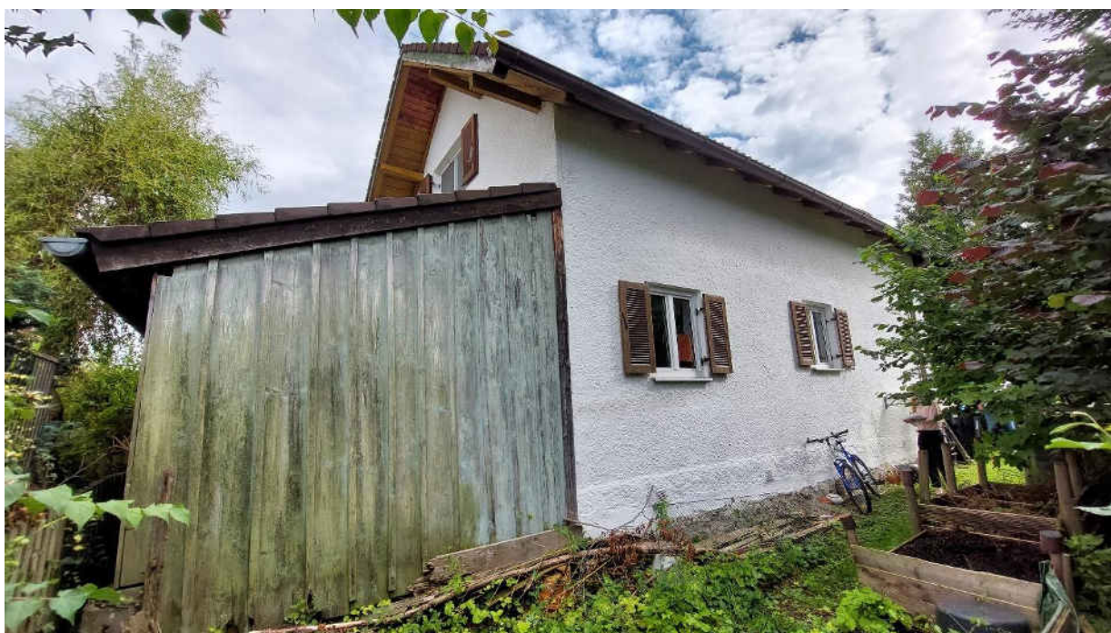
Foto 4 – Einfamilienhaus mit Schuppen von Nordwesten
