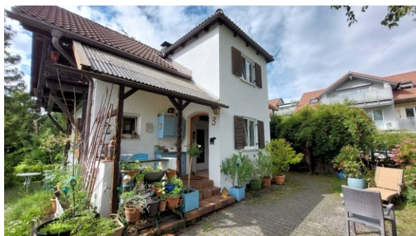
Best. Einfamilienhaus u. Schuppen v. Süden
