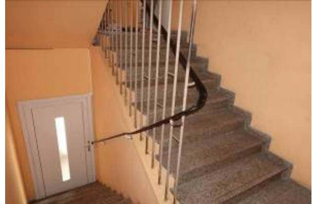
Treppe vom EG zum OG
