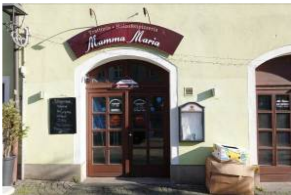
Zugang zum Restaurant im EG
