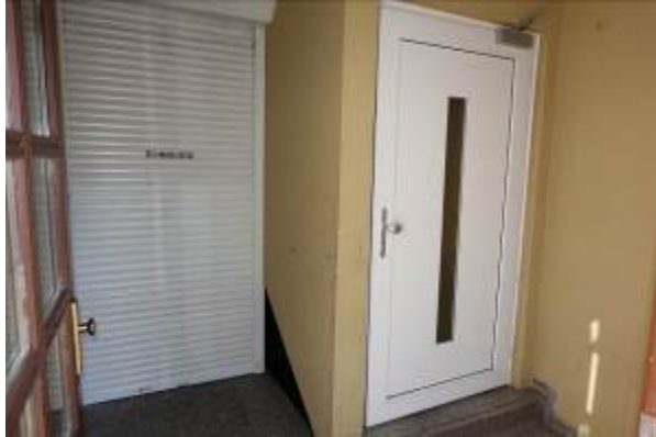
Zugang zum Treppenhaus und zu der Diskothek im UG
