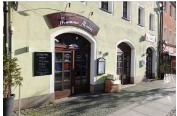
Zugang zum Restaurant im EG
