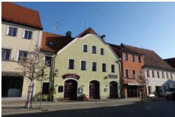
Bewertungsobjekt, Blick aus südwestlicher Richtung
