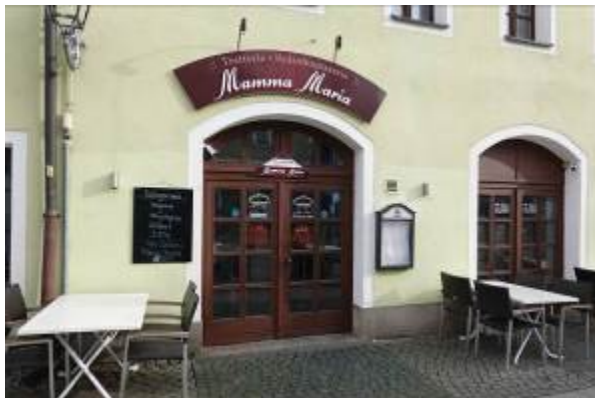
Zugang zum Restaurant im EG
