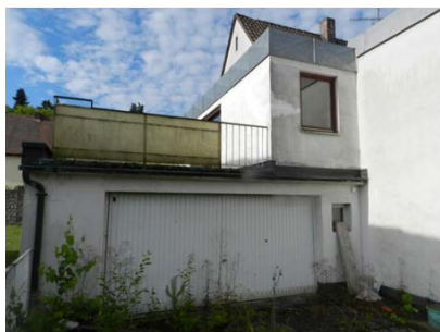
Blick auf Ostfassade
