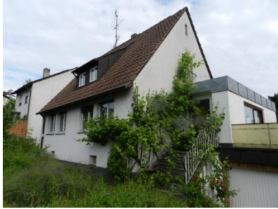
Ansicht von Ostgiebel und Südfassade; Hauseingang zur Wohnung Nr. 1
