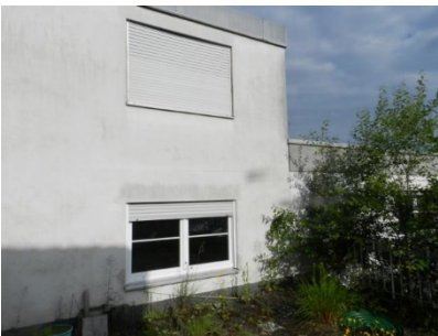
Blick auf Ostfassade
