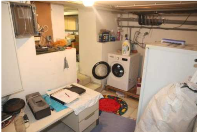
Teilunterkellerung – Flur (Treppenhaus)
