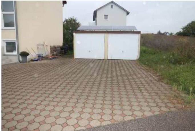
Garage – Ansicht von Süden
