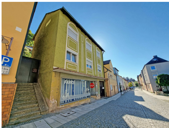
Hauptstr. 45 Hauptstr. 47 Ansicht von Westen
