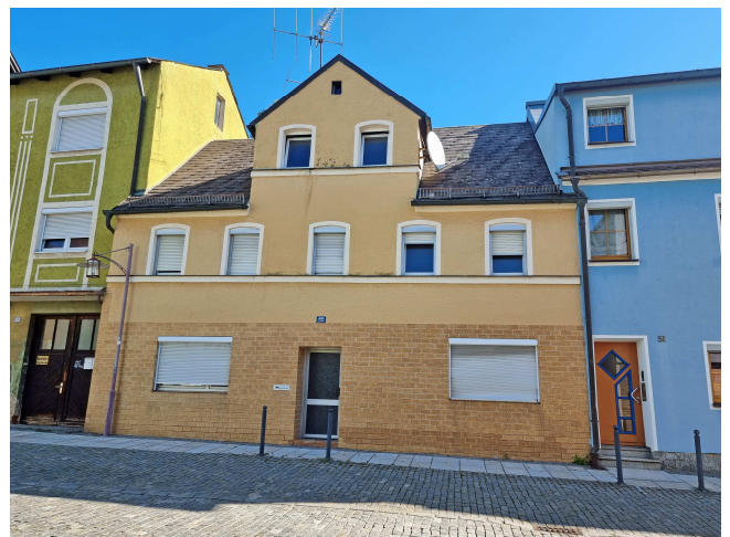
Hauptstr. 47 Wohnhaus Hauptstr. 49 Hauptstr. 51 Ansicht von Südwesten
