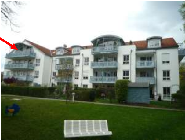
Gesamtansicht Haus A von Süden (Foto 2014)
