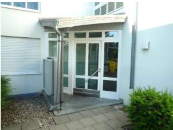
Hauseingang von Norden
