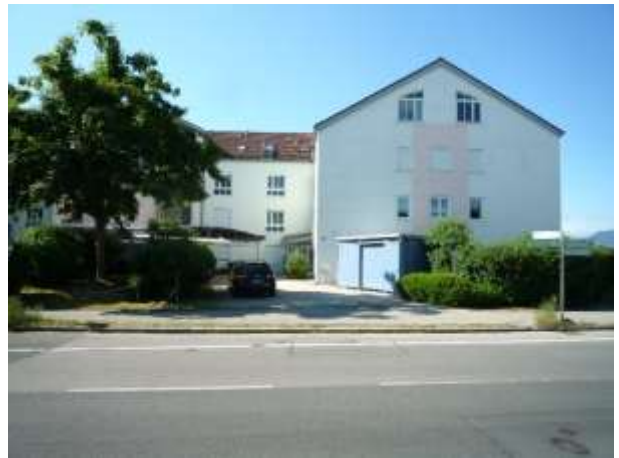
Ansicht von Norden (Haus A West)
