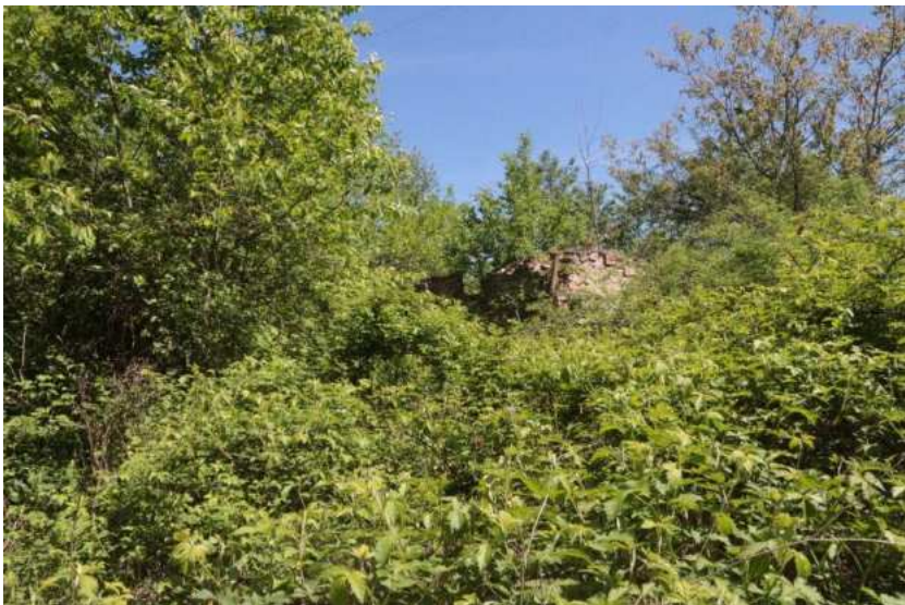
Ehemaliger Hofbereich, Gebäuderuine erkennbar (unkultivierte Fläche)
