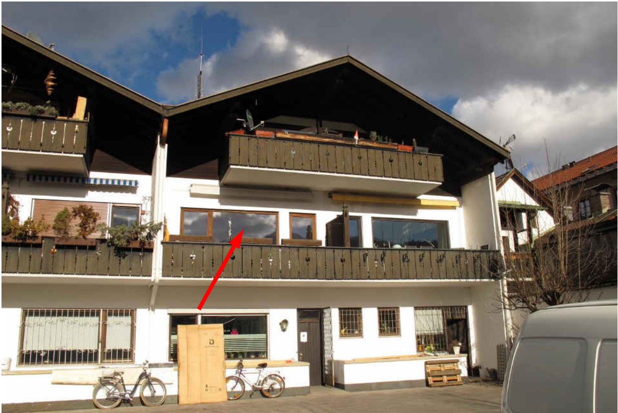
Foto 5 – Wohn- und Geschäftshaus von Südwesten, mit Blick auf den Balkon der Wohnung B
