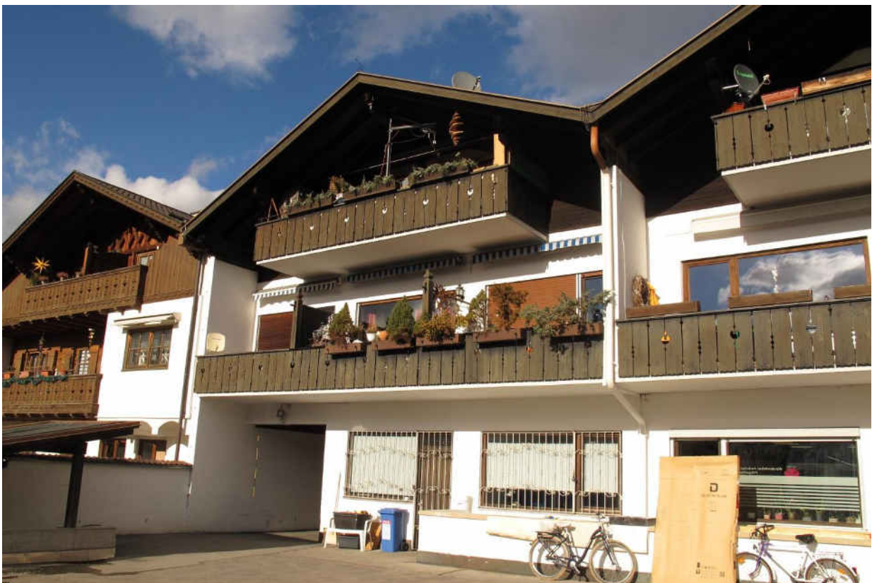
Foto 4 – Wohn- und Geschäftshaus von Südwesten (Hofseite)
