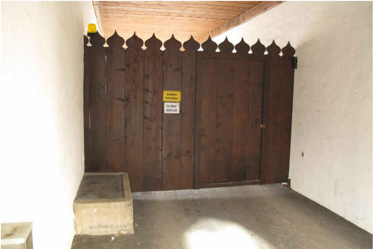
Foto 3 – Zufahrtstor zum Innenhof, von der Ludwigstraße
