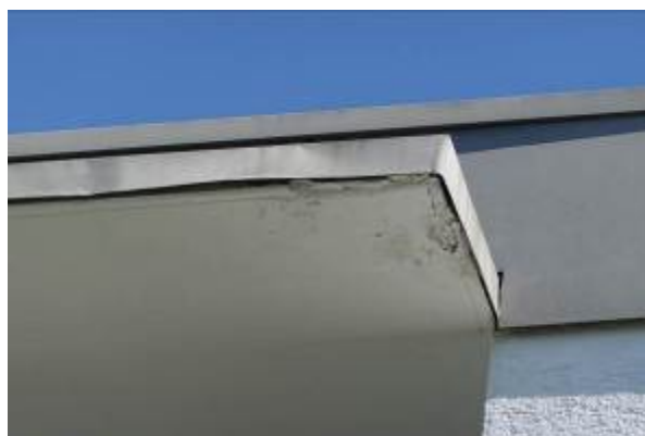
Instandsetzungsbedürftige Überdachung des Balkons der Wohnung Nr. 23 (3.OG)
