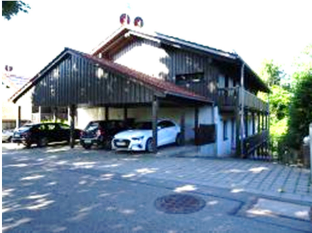
Nordostseite von der Sonnenlängstraße
