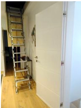
OG, Einschubtreppe in den Dachboden
