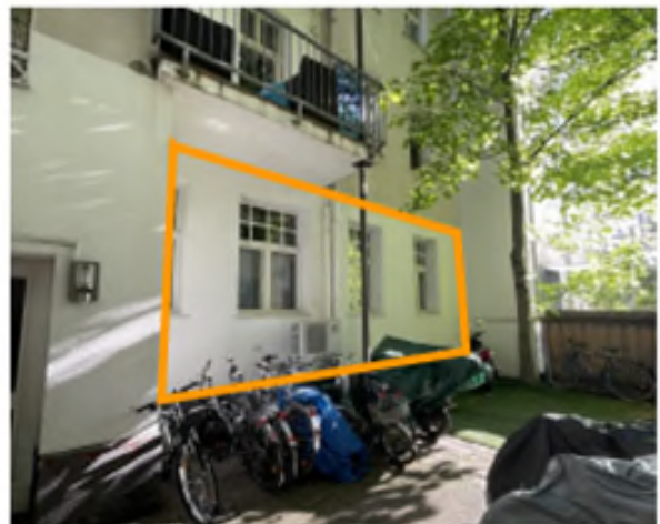
Rückwärtig von der Henkestraße gelegener Hofraum, Bewertungsobjekt lt. ATP Nr. 1 (markiert)
