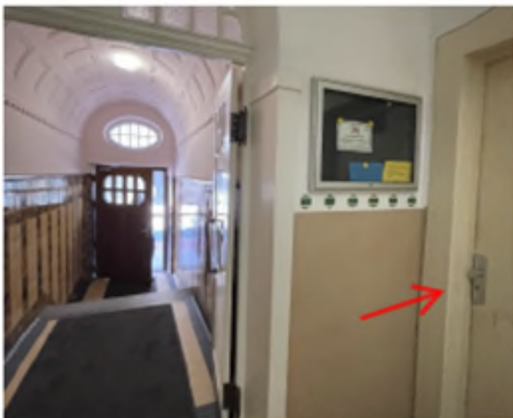
Ansicht Flur mit Zugang zum Bewertungsobjekt lt. ATP Nr. 1 (Pfeil)
