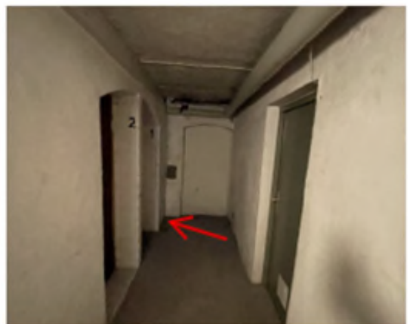
Ansicht Kellergang, Kellerraum lt. ATP Nr. 1 hinten links (Pfeil)
