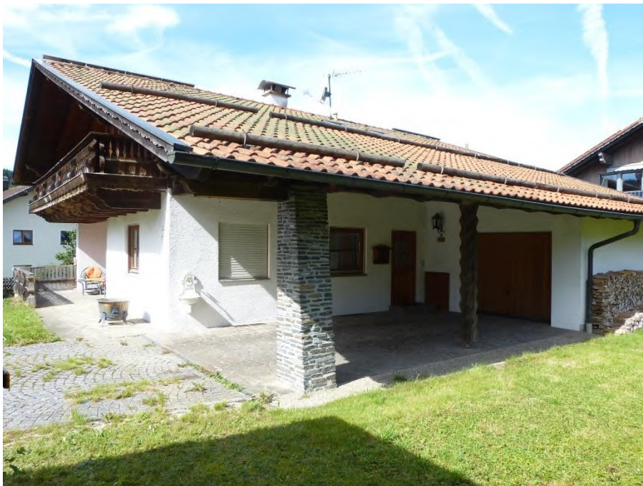
Gebäude 1 + 2: Einfamilienhaus mit Einliegerwohnung und Garagenanbau, Ansicht von Osten
