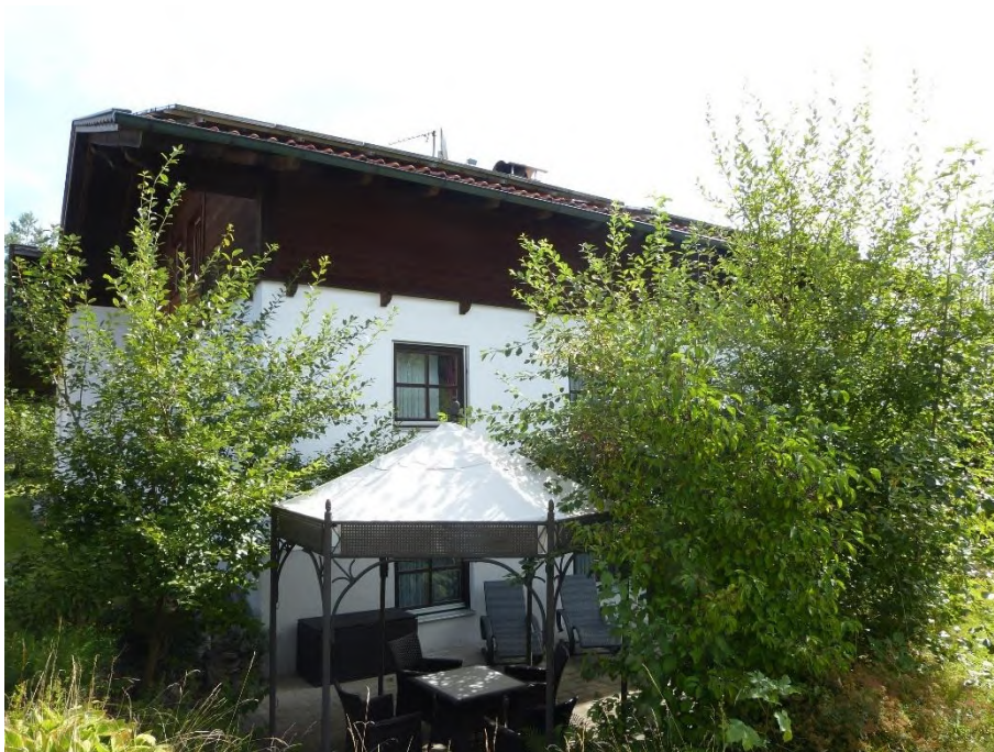
Gebäude 1: Einfamilienhaus mit Einliegerwohnung, Ansicht von Westen
