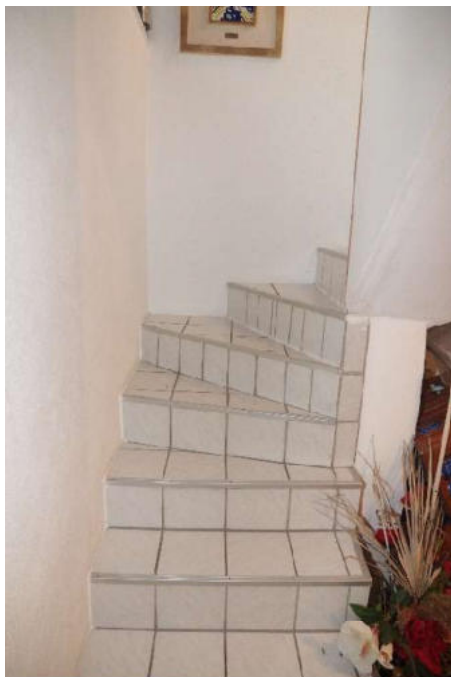
Treppe vom Keller zum Erdgeschoss
