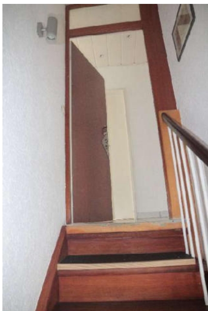
Zugang zur Wohnung Nr. II im Dachgeschoss
