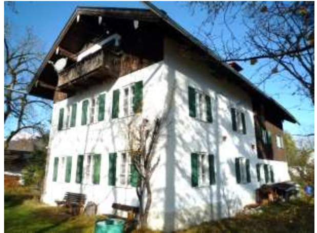
Ansicht von Südosten
