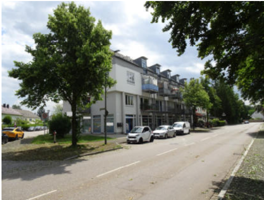
Südwest- und Nordwestseite des Gebäudes
