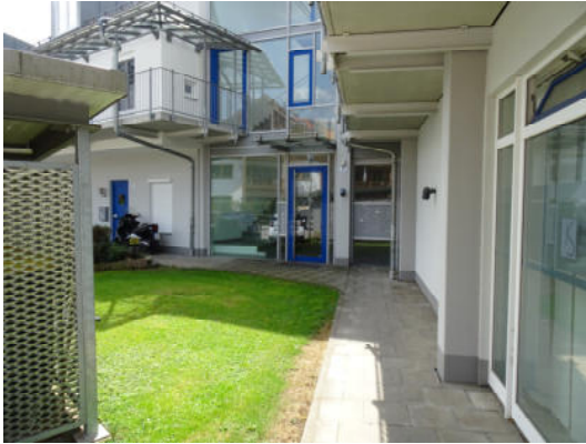
nördlicher Grundstücksbereich mit Hauseingang
