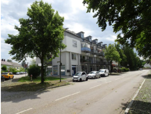
Südwest- und Nordwestseite des Gebäudes
