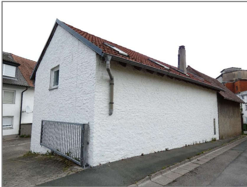
Nebengebäude - Ansicht von Südwesten
