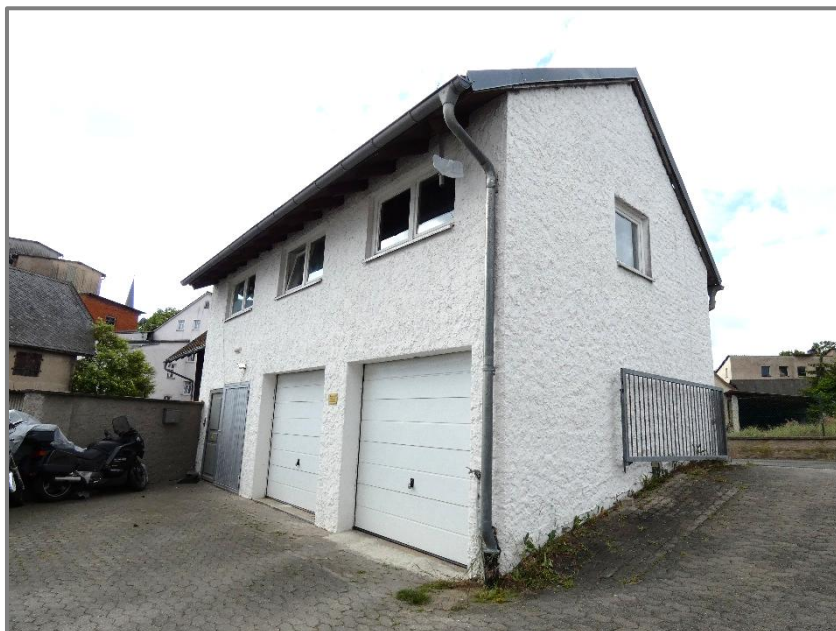
Nebengebäude - Ansicht von Nordwesten
