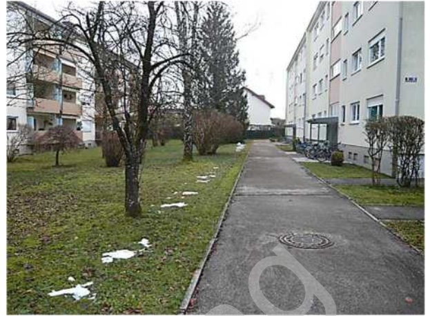
Grundstückszugang v. Nordwesten
