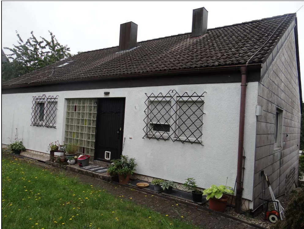
Bild 1: Blick auf das Wohngebäude von Nord-Westen
