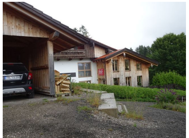
Carport mit Zufahrt zur Südseite der Doppelgarage
