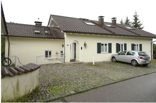
Nordseite Wohnhaus, Flurstück 975
