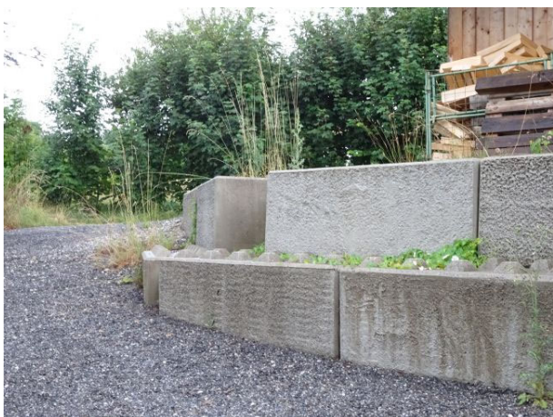
Flurstück 977/3, Abtreppung zum Carport
