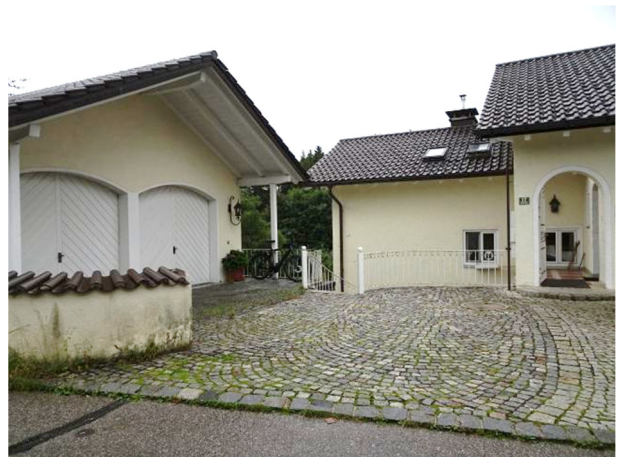
Flurstück 975/1, Zufahrt Doppelgarage/Zugang zur Wendeltreppe
