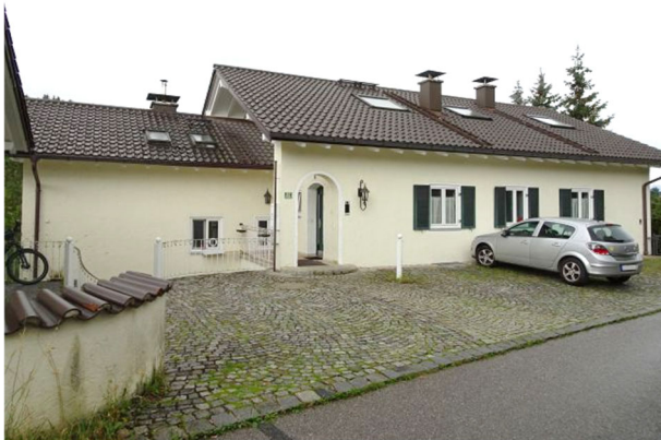
Nordseite Wohnhaus, Flurstück 975
