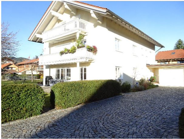
Süd- und Ostseite mit Zufahrt
