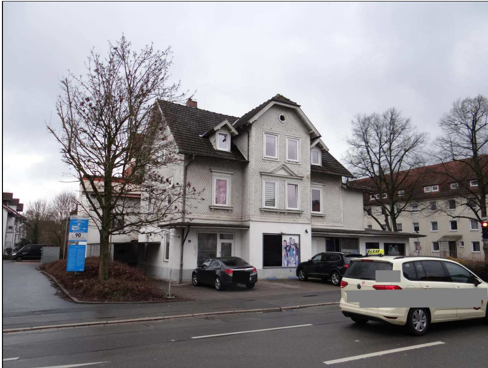
Bild 1: Blick auf das Anwesen von Norden
