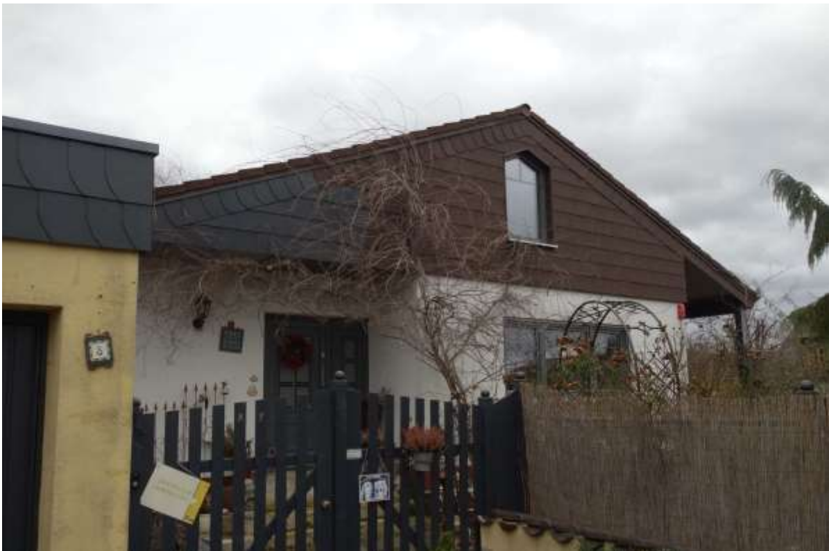
Abbildung 2: Hauseingangsbereich und westliche Giebelseite
