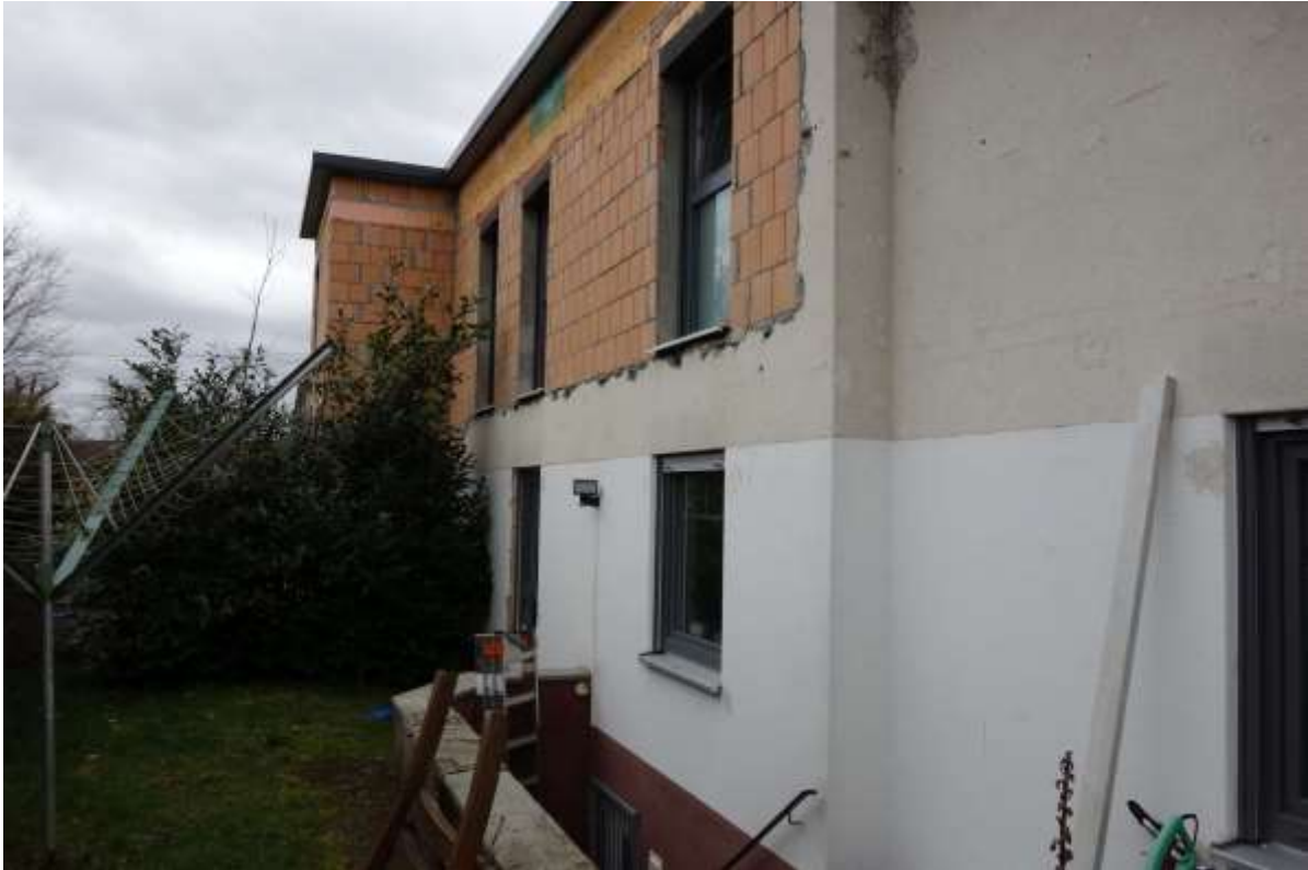
Abbildung 5: Östliche Fassadenseite mit Bestand im EG und Neubau im OG
