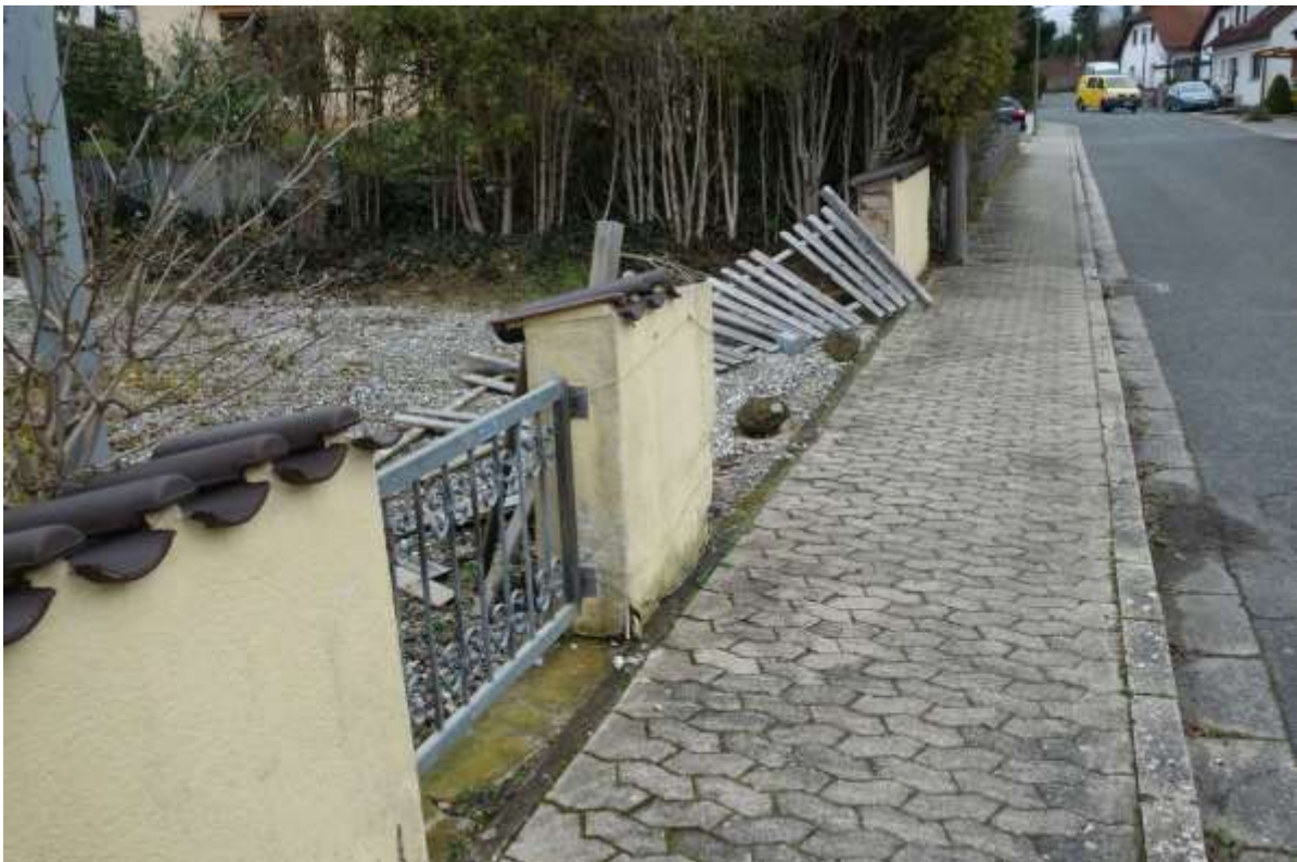
Abbildung 10: Einfriedung mit Zufahrt über die Südseite zum Büroanbau
