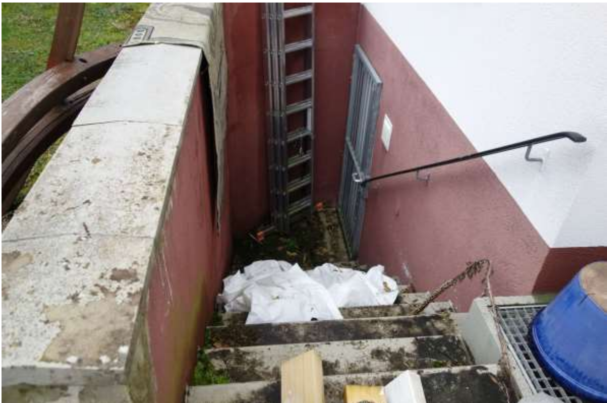
Abbildung 6: Kelleraußentreppe auf der Ostseite des Wohnhausanbaus
