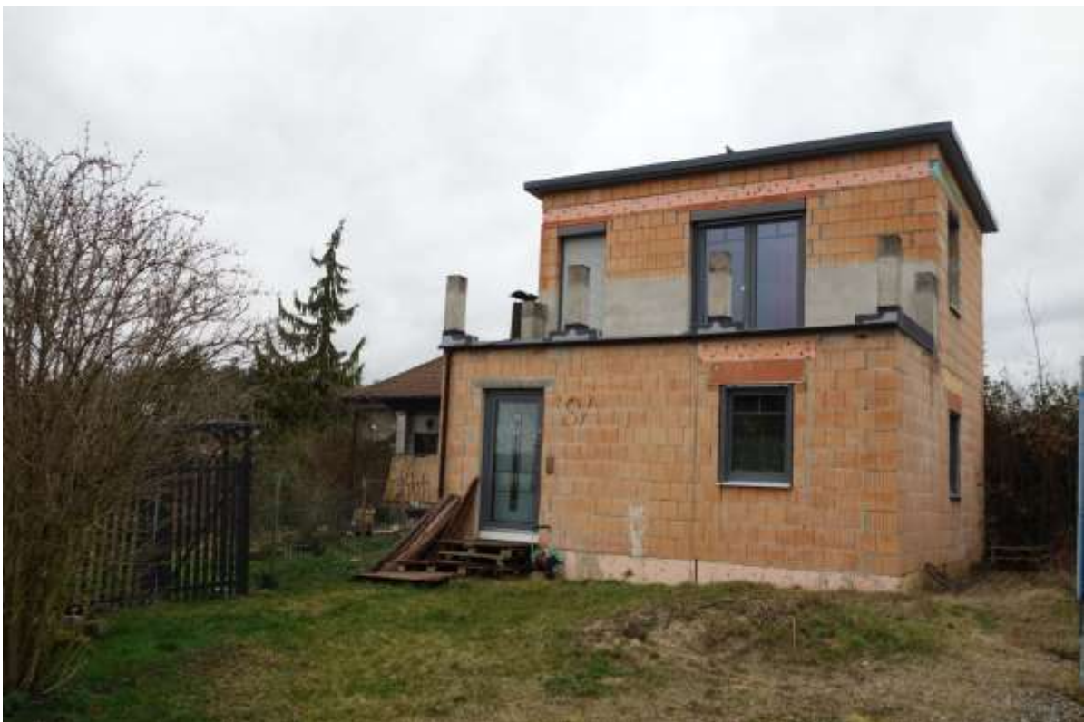
Abbildung 8: Büroanbau mit Dachterrasse im OG
