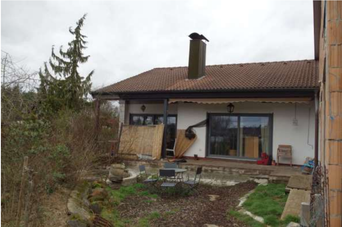
Abbildung 9: Grundstück mit umfangreichen Betonbeständen vor der Terrasse
