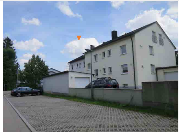
Ansicht von Nordwesten (Bewertungsobjekt rückwärtig, siehe Pfeil)
