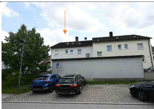
Objektansicht von Norden (Pfeil = BO)
