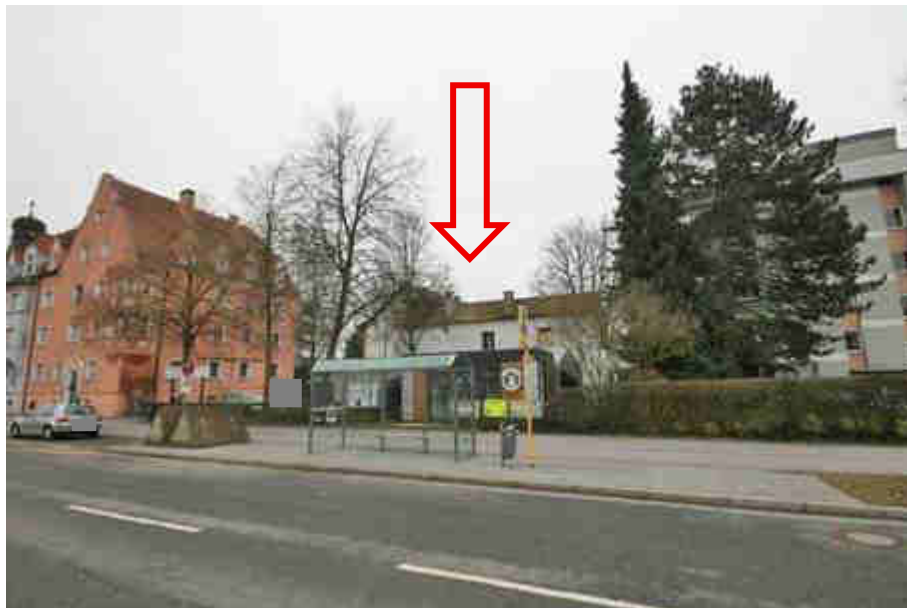
Blick auf Wertermittlungsgrundstück von Nordwesten mit östlich und westlich angrenzender Bebauung, im Bildvordergrund Altdorferstraße
