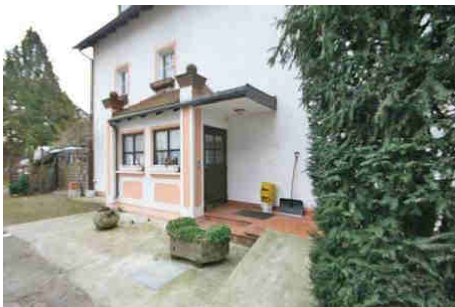
Blick auf Hauszugang zum Gebäude 1
