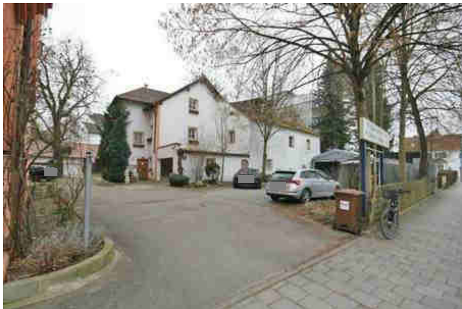
Blick auf Wertermittlungsgrundstück und Gebäude 1 und 1b von Nordosten mit Zufahrt von der Altdorferstraße
