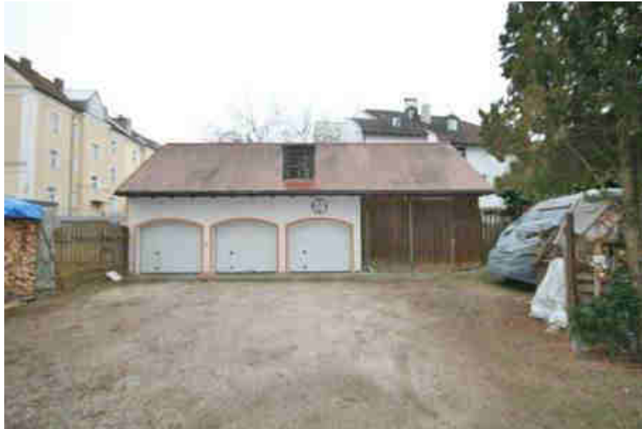
Blick von Norden auf Gebäude 4
