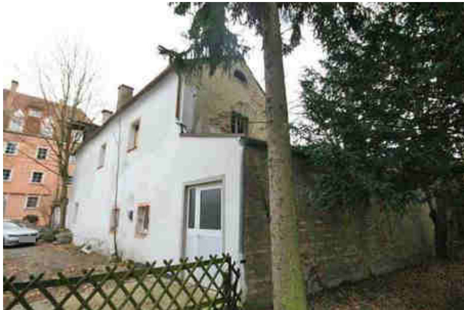
Blick von Nordwesten auf an der westlichen Grundstücksgrenze grenzständigen, nordwestlichen Anbau (Gebäude 1b)
