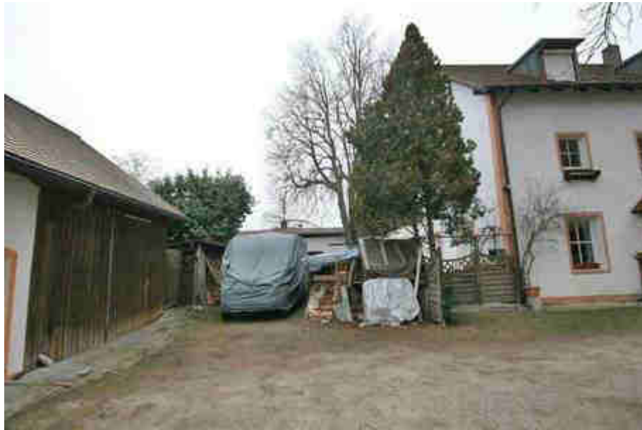
Blick von Osten auf südlichen Grundstücksbereich, links im Bild westlicher Teil Gebäude 4, rechts im Bild südlicher Teil Gebäude 1
