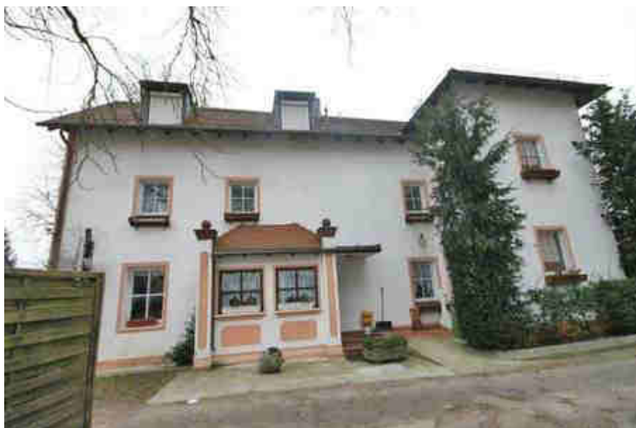
Blick von Osten auf Gebäude 1
