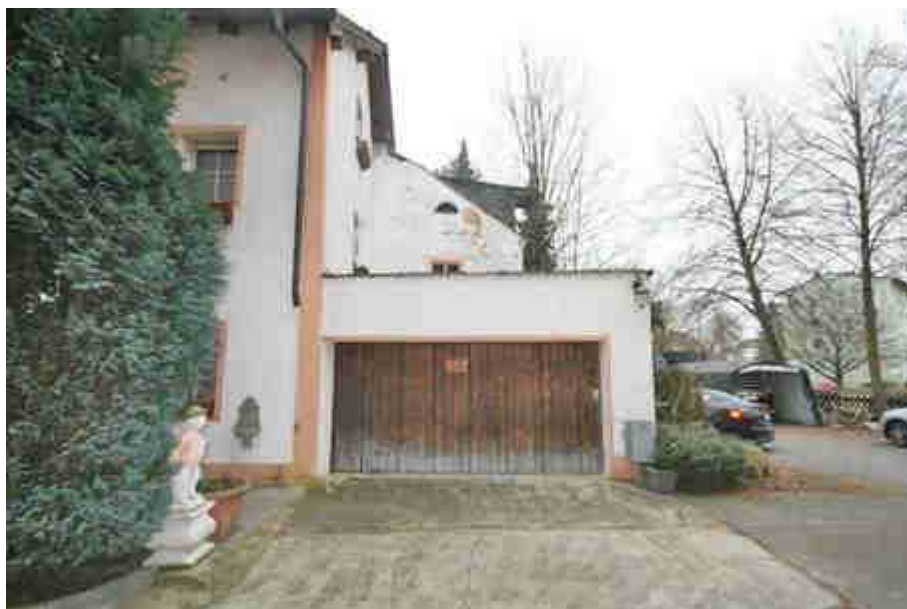
Blick von Osten auf an Gebäude 1 (links angeschnitten) angebautes Garagengebäude (Gebäude 3), im Bildhintergrund Gebäude 1b
