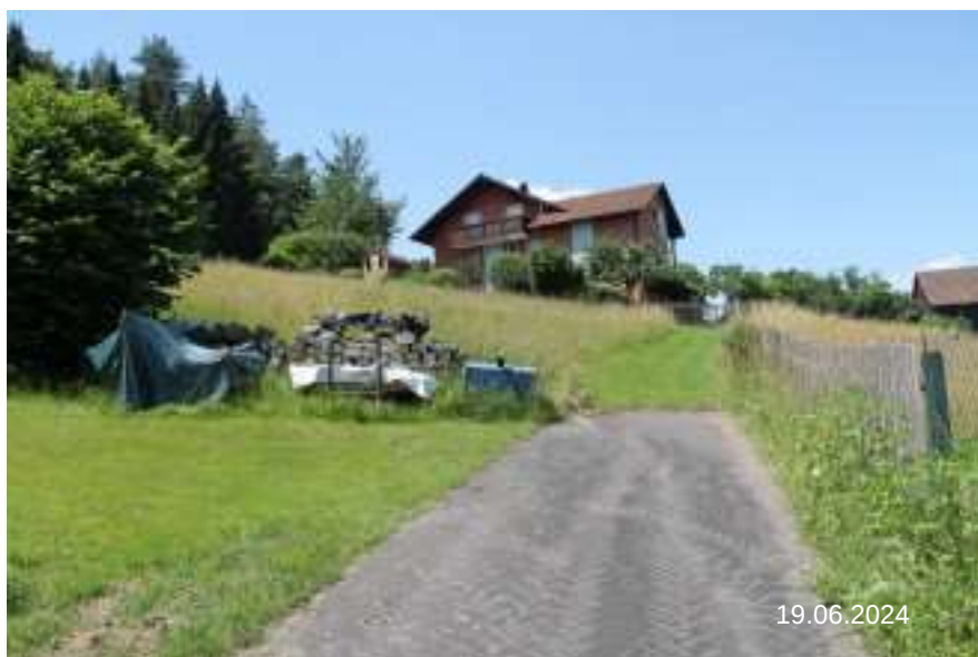
Bild 1 Ansicht Grundstück von Nordosten – Zu- fahrt auf Nachbar- grundstück
