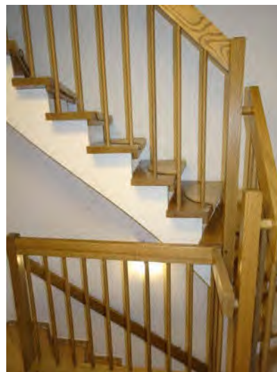
Treppenlauf OG - DG
