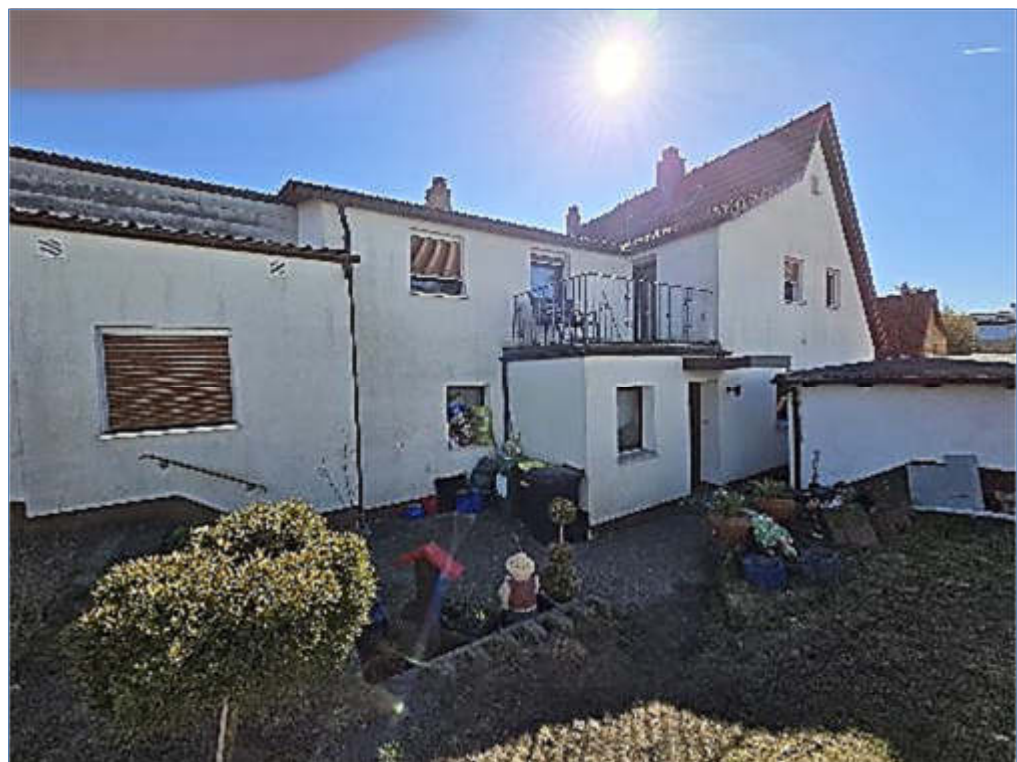
Bild 4 Pos. 01 Wohnhaus, Nordseite
