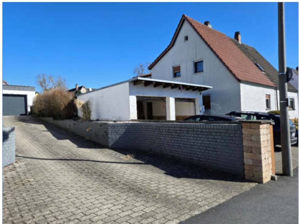
Bild 2 Pos. 01 Wohnhaus und BBT Garage, Nord- und Westseite
