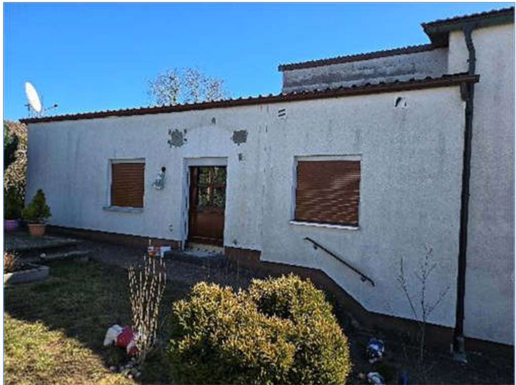
Bild 5 Pos. 01 Wohnhaus, Nordseite
