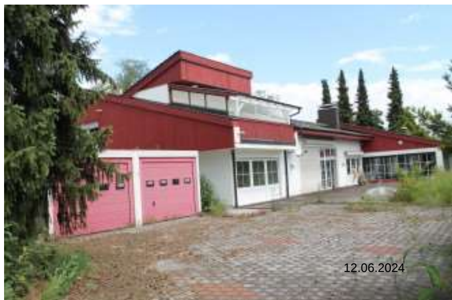
Bild 12: Fl.Nr. 98 Ansicht Wohnhaus + Schwimmbad von Südwesten
