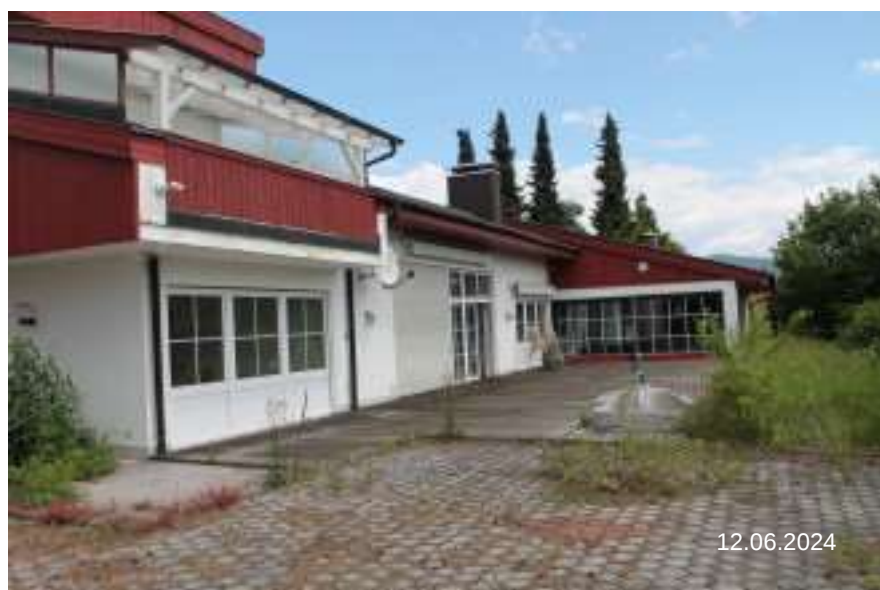
Bild 9: Fl.Nr. 98 Ansicht Wohnhaus + Schwimmbad von Südwesten
