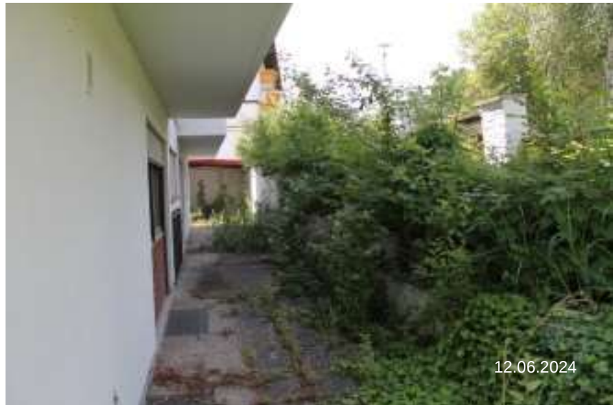
Bild 14: Fl.Nr. 98 Ansicht Nordseite Wohnhaus von Osten
