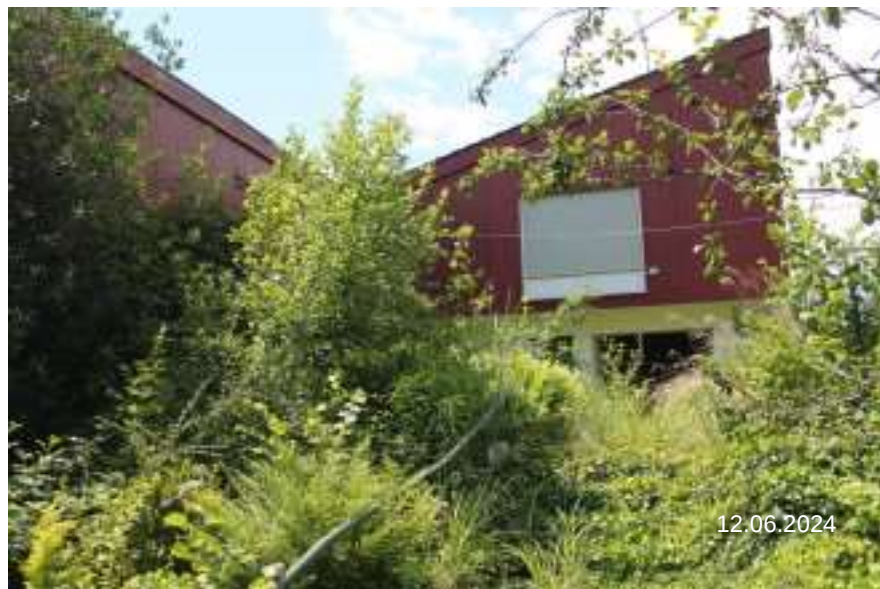
Bild 8: Fl.Nr. 98 Ansicht Wohnhaus + Schwimmbad von Nordosten
