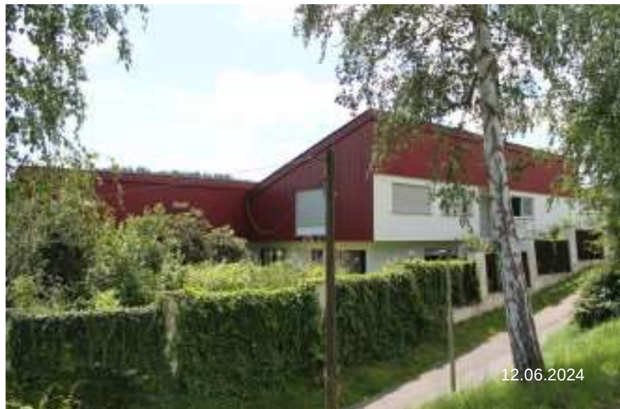
Bild 2: Fl.Nr. 98 Ansicht Wohnhaus + Schwimmbad von Nordwesten
