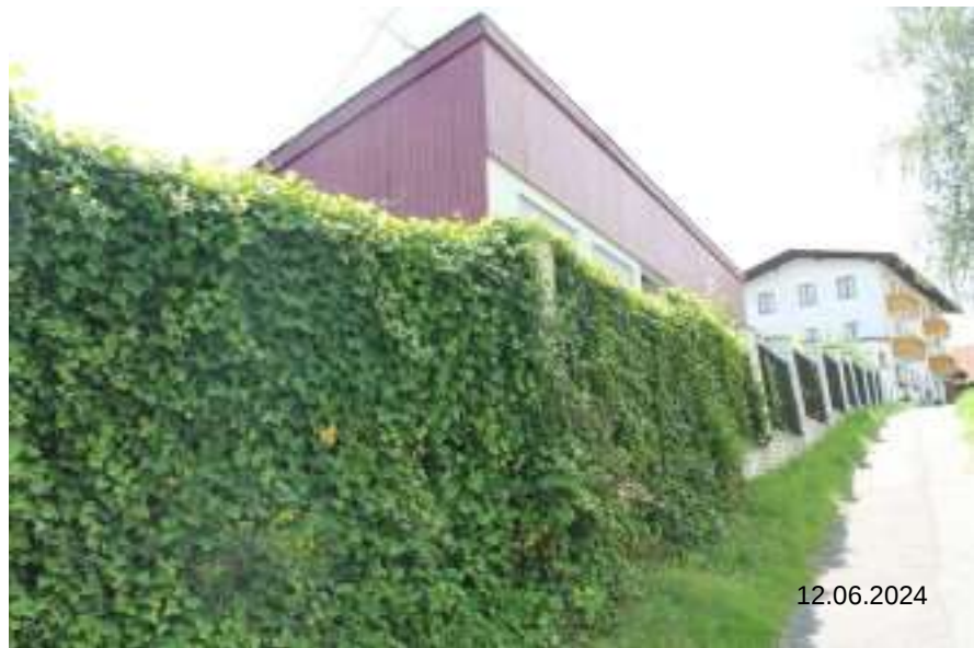
Bild 4: Fl.Nr. 98 Ansicht Wohnhaus von Osten
