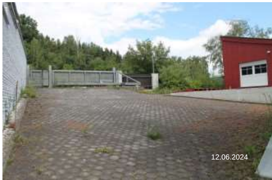
Bild 11: Fl.Nr. 98 Ansicht Zufahrt Westen von Süden
