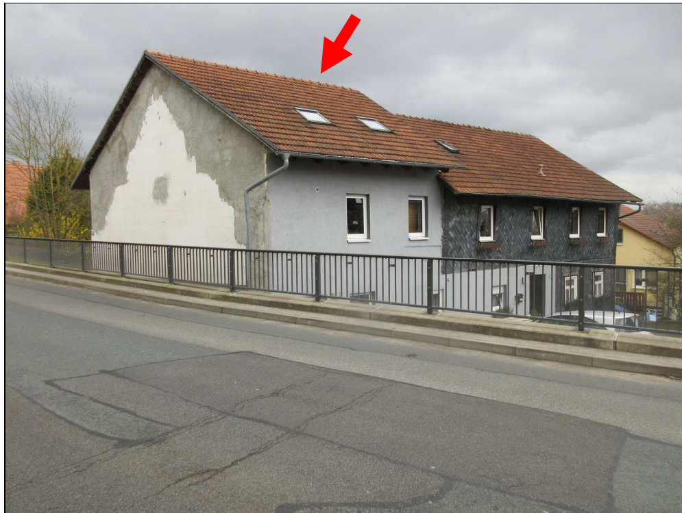
Bild 1: Blick auf die Doppelhaushälfte Hs.Nr. 18 a von Norden
