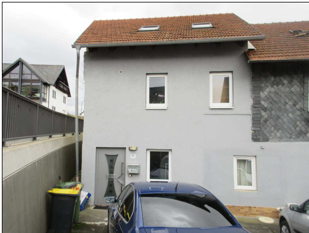
Bild 2: Nord-West-Ansicht der Doppelhaushälfte
