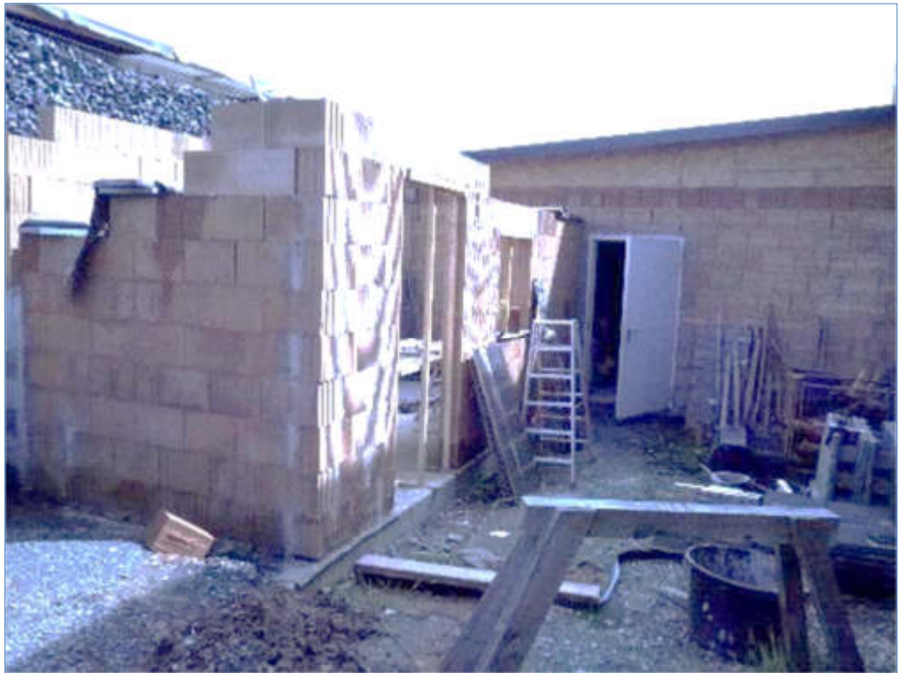
Bild 5 BBT Garage und Schuppen, Nordseite
