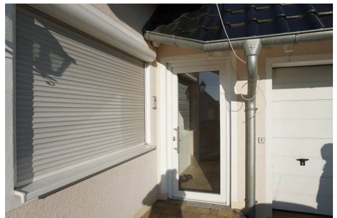
Hauseingang an der Südfassade am Garagenanbau
