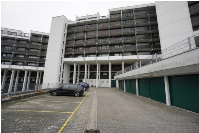
Zufahrt Ebene 1 Gemeinschaftseigentum Blick Richtung Südosten Stellplätze
