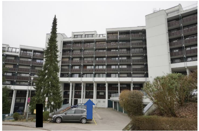
Wohnhaus Nr. 25 Gemeinschaftseigentum Nordwestansicht
