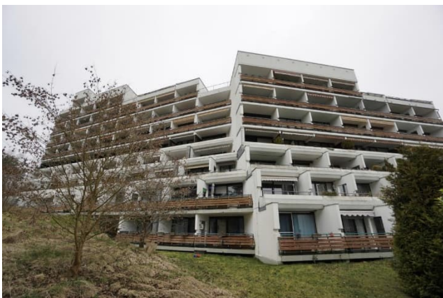
Wohnhaus Gemeinschaftseigentum Südostansicht
