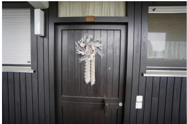
Wohnhaus Ebene 2 Gemeinschaftseigentum Eingang Wohnung 13
