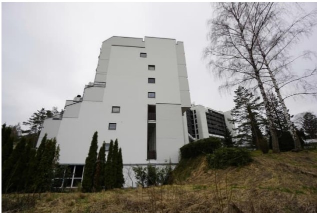
Wohnhaus Gemeinschaftseigentum Nordansicht
