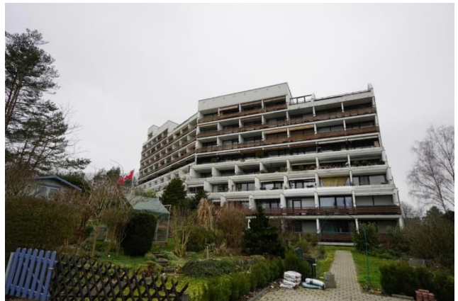
Wohnhaus Gemeinschaftseigentum Ostansicht
