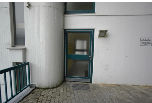
Wohnhaus Ebene 1 Gemeinschaftseigentum Eingang Treppenhaus
