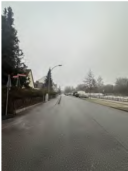
Beispielhafte Ansicht der Angerstraße Richtung Nordost
